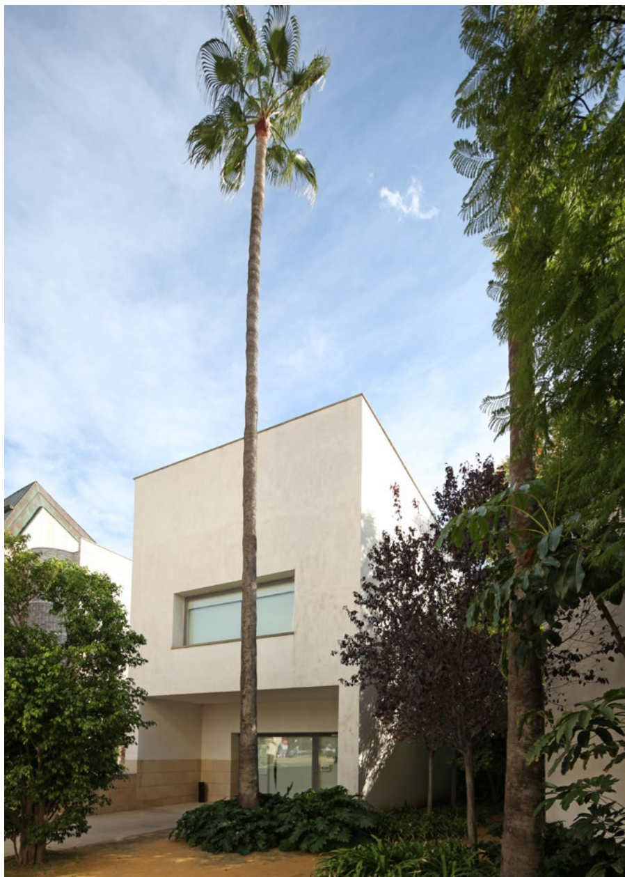
Vista del pati exterior de l'edifici del Rectorat i Serveis Generals. Foto: Arxiu UA.
