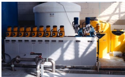
Sistema de dosificació de reactius de pretractament i postractament. Foto: M. F. Chillón.
