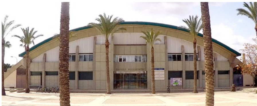
Entrada al Pavelló Poliesportiu universitari. Foto: Arxiu UA.
