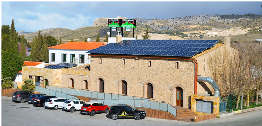
Instal·lació de plaques solars fotovoltaïques destinades a l'autoconsum en un restaurant de carretera. Foto: Ijes Solar.
