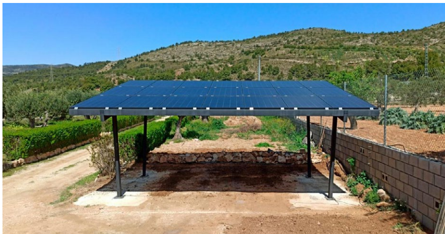
Instal·lació de plaques fotovoltaïques en una vivenda aïllada creant l'estructura d'un aparcament. Foto: Ijes Solar.
