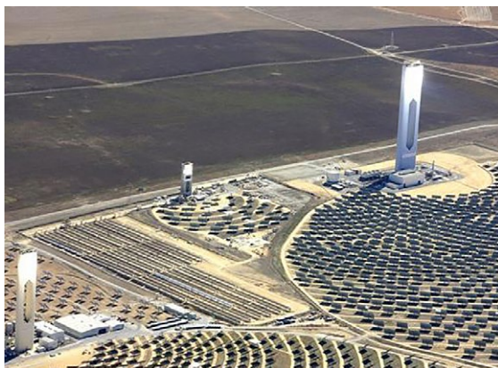
Planta de torre en la plataforma Solúcar a Sevilla. Foto: Abengoa.com.
